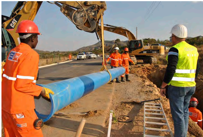
In Lubango, der Hauptstadt der angolanischen Provinz Huíla, leitet GAUFF Engineering die Neugestaltung und Sanierung der Wasserversorgung und Abwasserbeseitigung.
