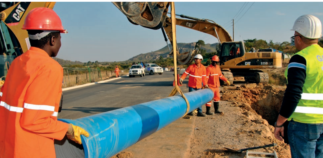
Sanierung der Wasserversorgung sowie Abwasserentsorgung in der Stadt Lubango in Angola.
