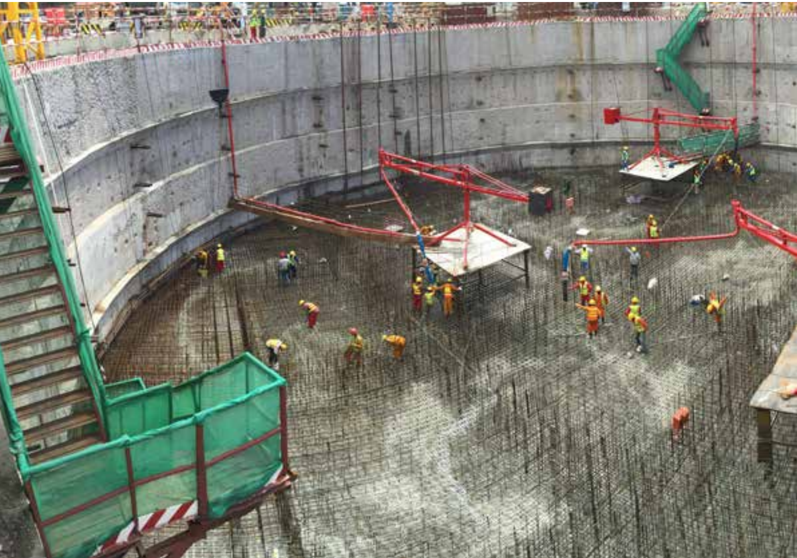
Betonarbeiten im Schacht des Ankerblocks.
