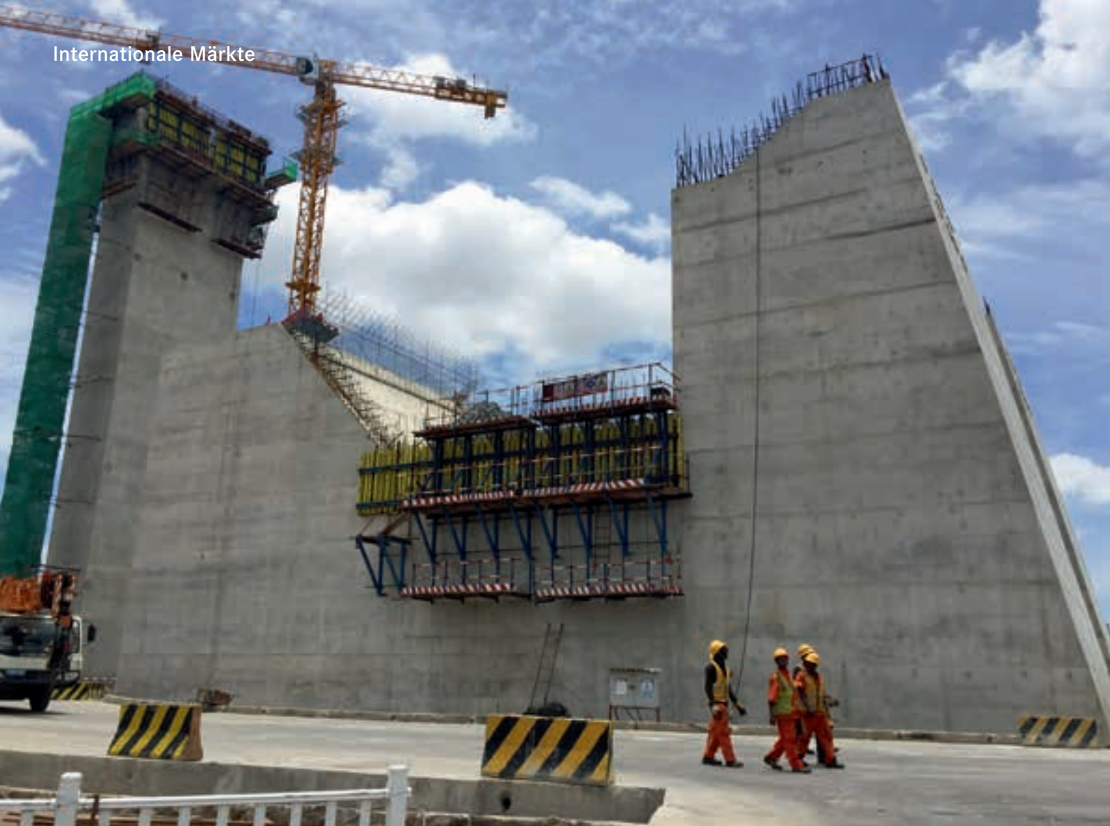
Der 170.000 t schwere Ankerblock auf der Nordseite.
