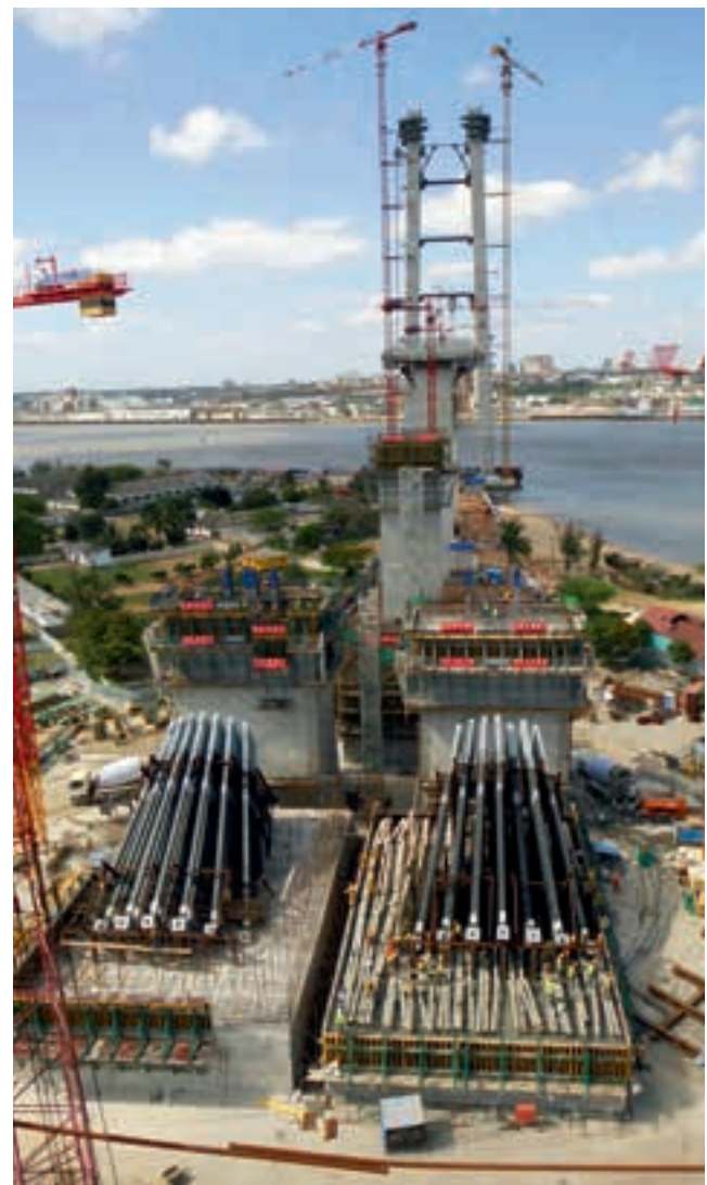
Am Ankerblock Süd werden die Stahlträger für die Brückenseile montiert.
