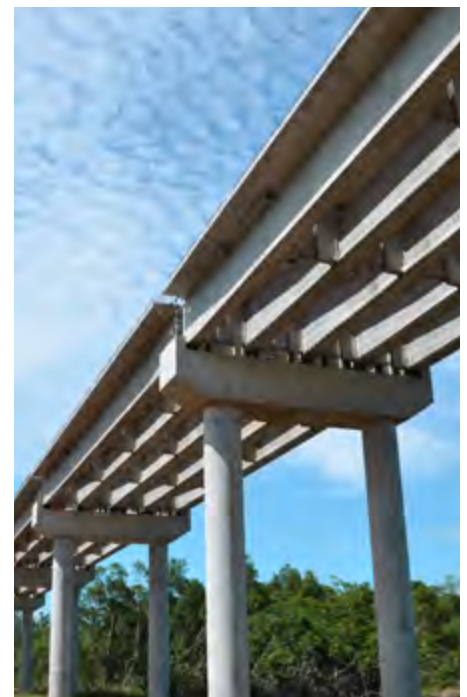
In Gabun überwacht GAUFF Engineering den Bau der beiden längsten Brücken Afrikas. © GAUFF GmbH & Co. Engineering KG
