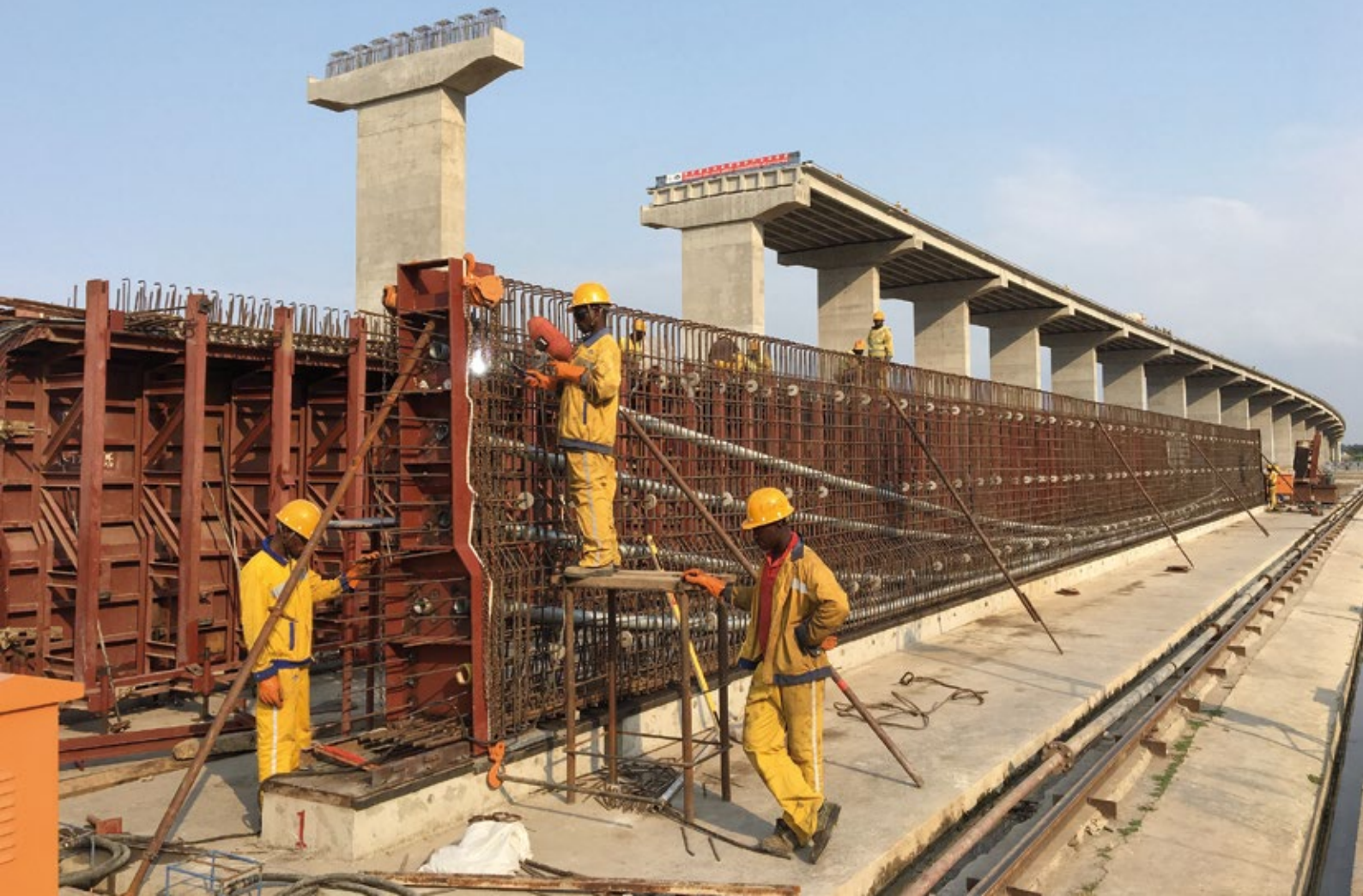
Abb. 5 (Bild oben) Bewehrungsarbeiten für die 45 m langen Stahlbetonfertigteile in der Fertigungsstraße auf der Südseite
