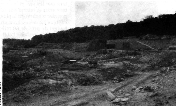
Lit de l'Ogooué. C'est ici que sera érigé le grand barrage.
