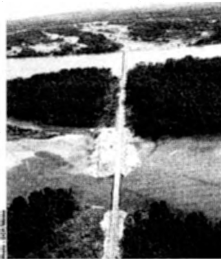
Une vue de l'un des ouvrages réalisés à mi-parcours.
