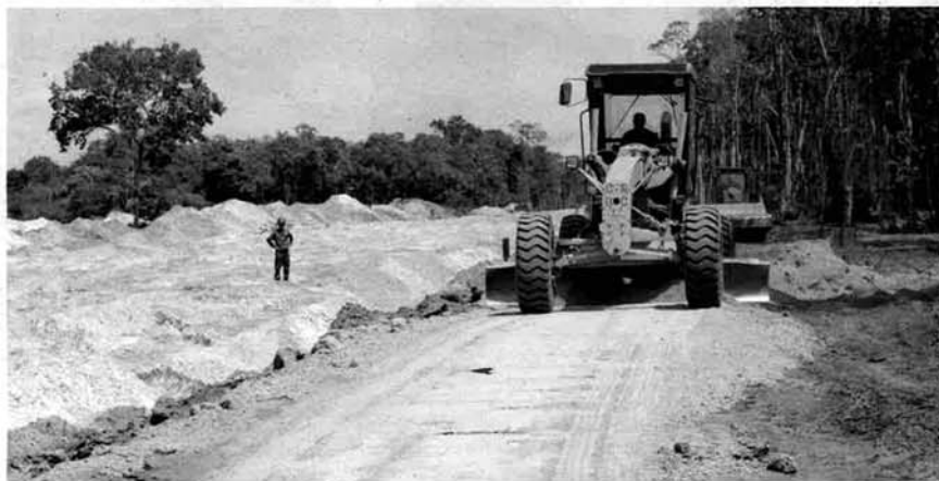
Une niveleuse répand de la latérite sur la route.
